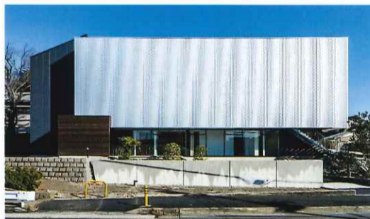
綾瀬市商工会 新商工会館 (災害時には一時避難場所として地域経済の復興拠点としても位置づけられている)
